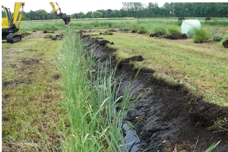
Figuur 23: Aanlegwerkzaamheden pilot Aarle-Rixtel.
